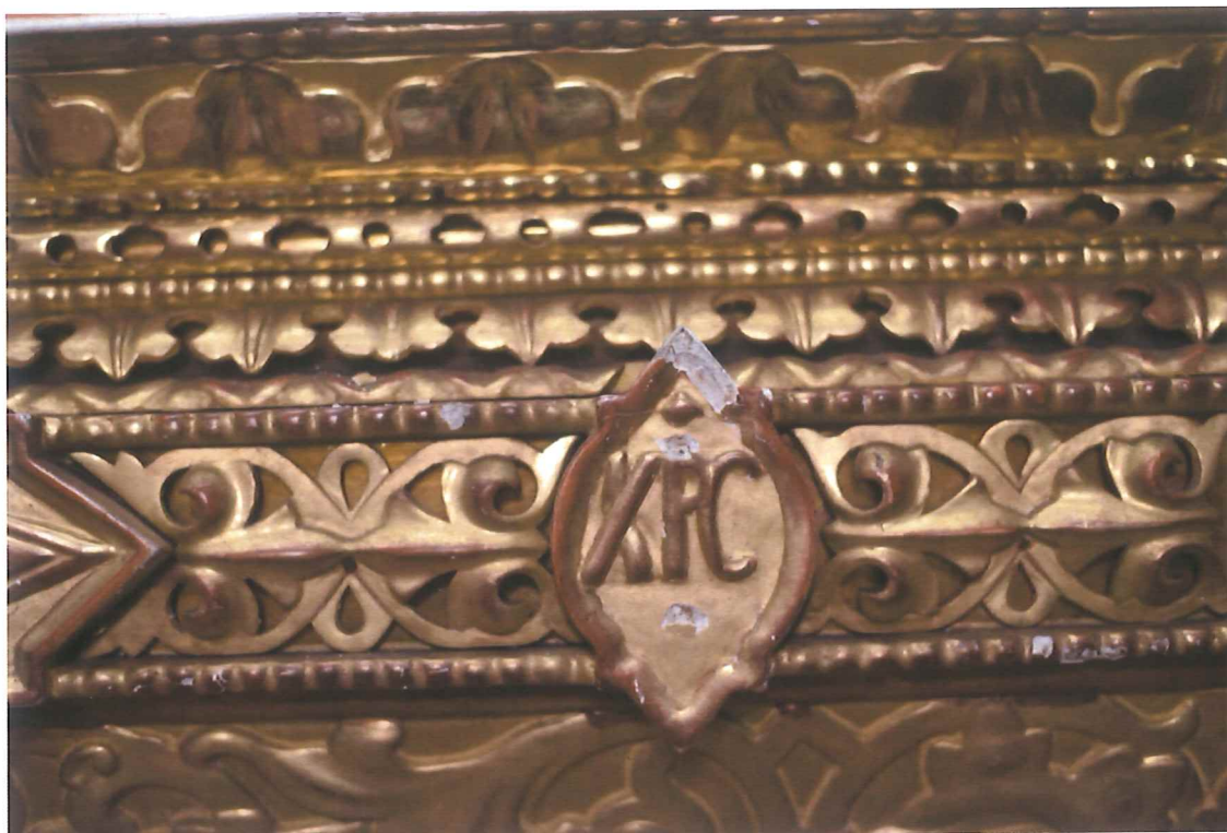
Fot. nr 5 – Cerkiew Prawosławna P.W. Zaśnięcia N.M.P. w Hrubieszowie, ul. 3 – Go Maja. Grób Chrystusa – widoczne zniszczenia gruntów i złoteń.
